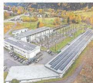
Wasser wird auf dem Kraftwerk Außerfragant gefasst.
