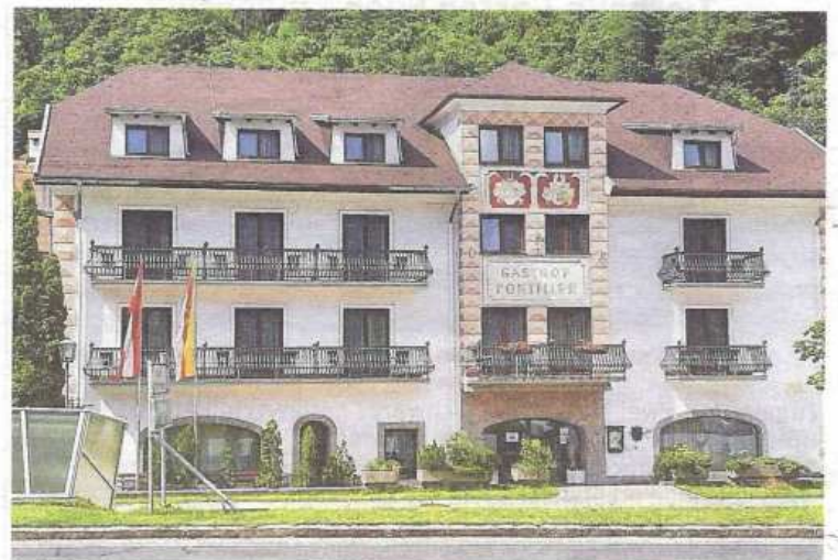
Das Traditionsgasthaus dürfte laut einem Häuserverzeichnis 1758 errichtet worden sein
